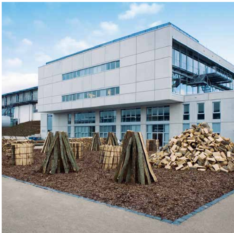
La biomassa contribuisce ad alimentare la centrale termica delle sede Viessmann di Allendorf (Germania)
